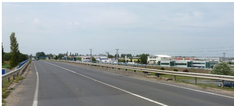
4. kép: A 62. sz főút 43+325 km szelvényében az M7 autópálya feletti híd, mely nem alkalmas kerékpáros létesítmény átvezetésére (forrás: Egységes Hídnyilvántartási Rendszer 22 )
