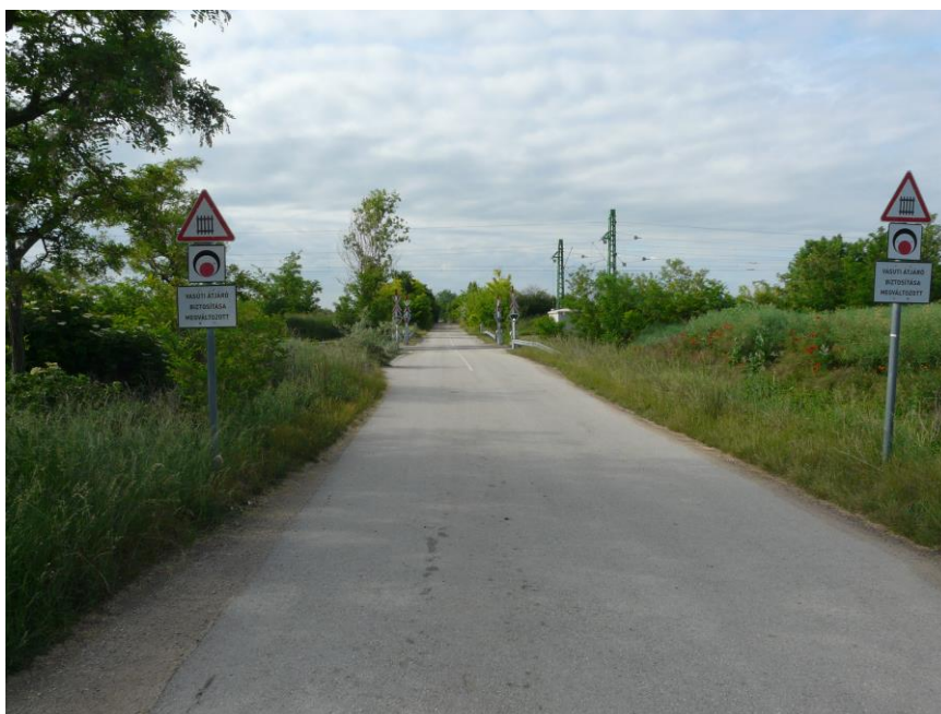
2. kép: A 30a számú Budapest- Székesfehérvár vasútvonal fény-és félsorompóval biztosított vasúti átjárója Börgöndnél (fotó: Papp Márton)
