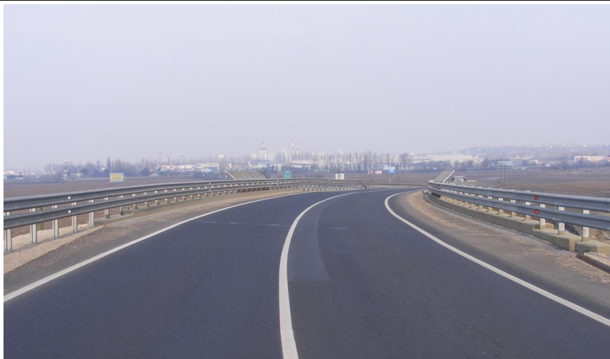
1. kép: A 30a számú Budapest- Székesfehérvár vasútvonal felett, a 62. sz. főút 41+325 km szelvényében lévő közúti felüljáró, mely nem alkalmas kerékpáros létesítmény átvezetésére (forrás: Egységes Hídnyilvántartási Rendszer 21 )
